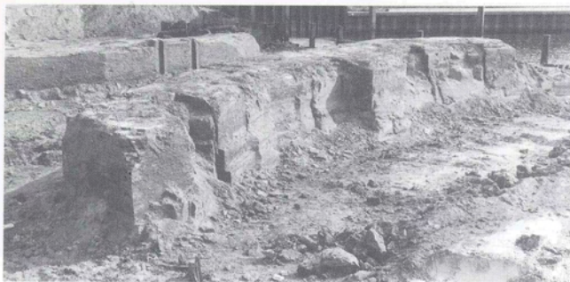
Foto van de onderzochte sluis (Foto: BAD)
